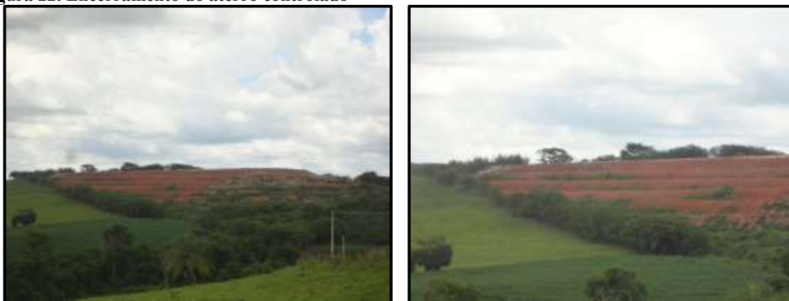
Figura 22. Encerramento do aterro controlado
