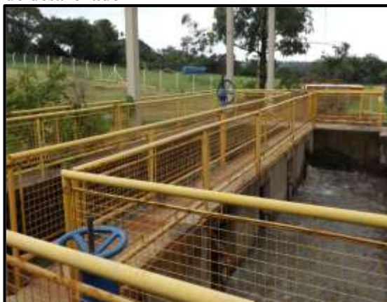
Figura 14. Canal de entrada do desarenador
