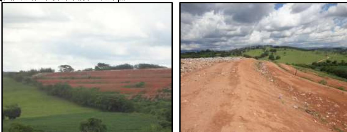
Figura 4. Aterro Controlado Municipal
