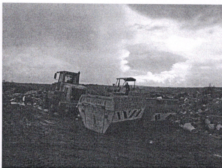
Figura 3 - Maquinário trabalhando na área do aterro desativado.
