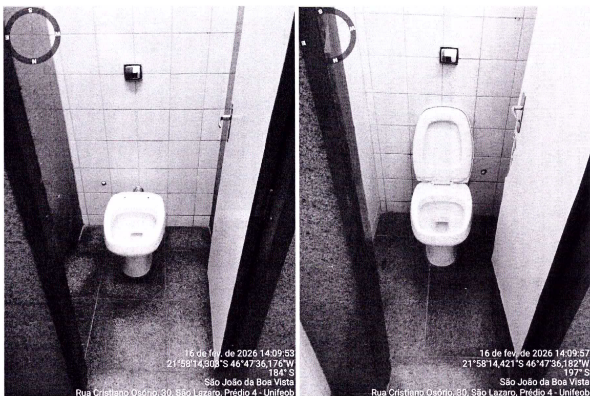
46 - Foto do banheiro - pavimento térreo.
