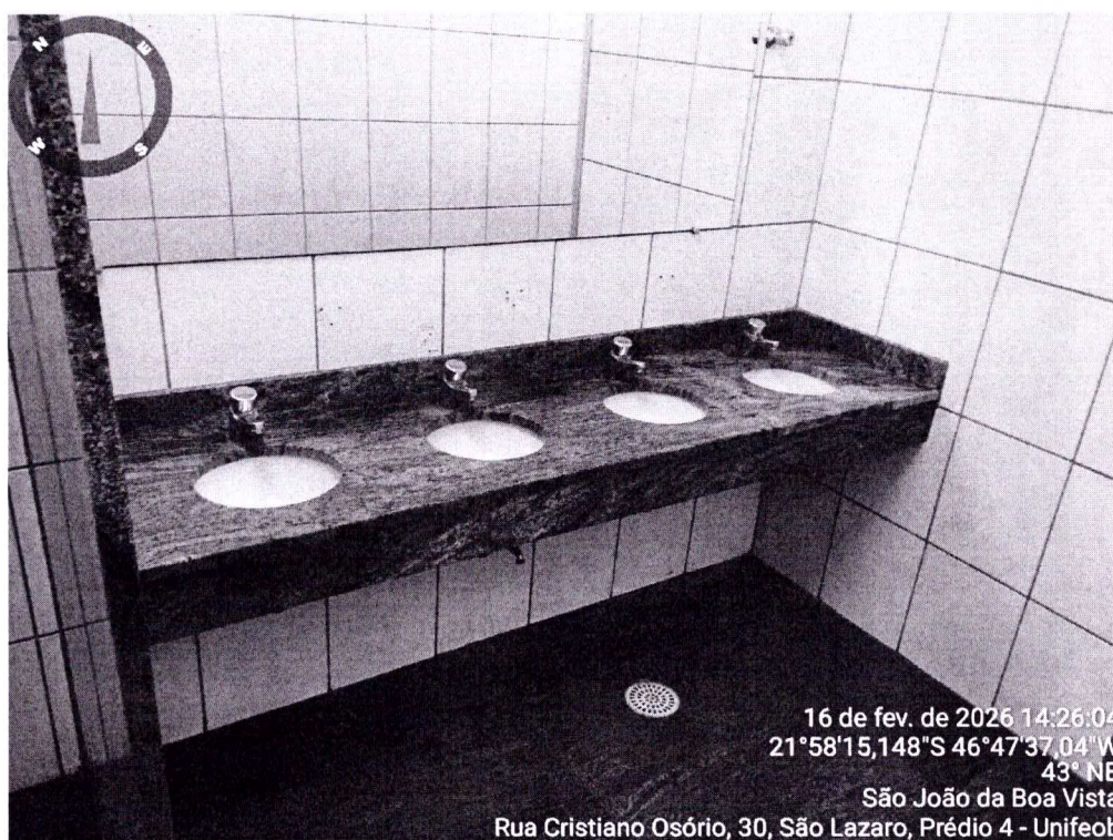
70 - Foto do banheiro - pavimento inferior.
