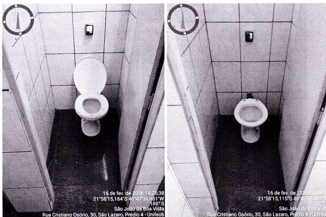
69 - Foto do banheiro - pavimento inferior.
