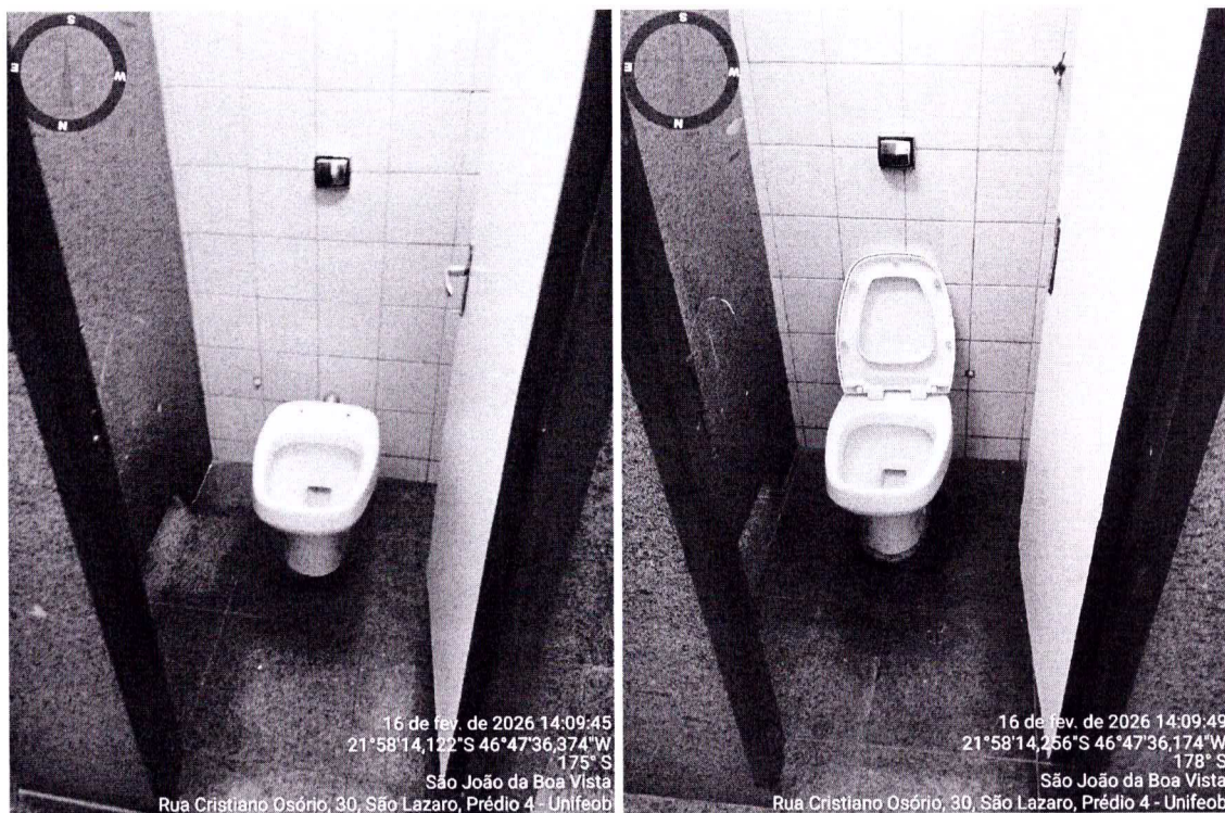
45 - Foto do banheiro - pavimento térreo.
