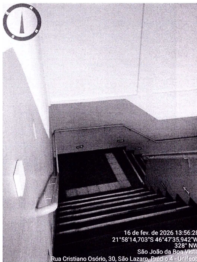
24 - Foto da escada - pav.superior.
