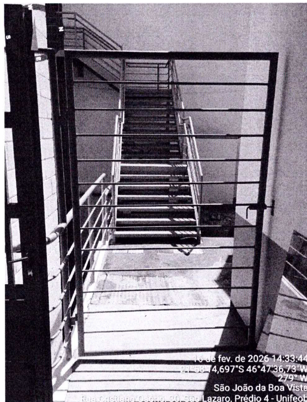
20 - Foto do portão de acesso à escada de emergência, corredor externo.
