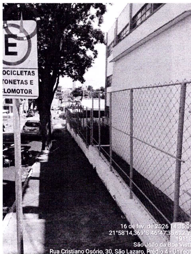
02 - Foto da fachada - Rua Cristiano Osório, nº 30
