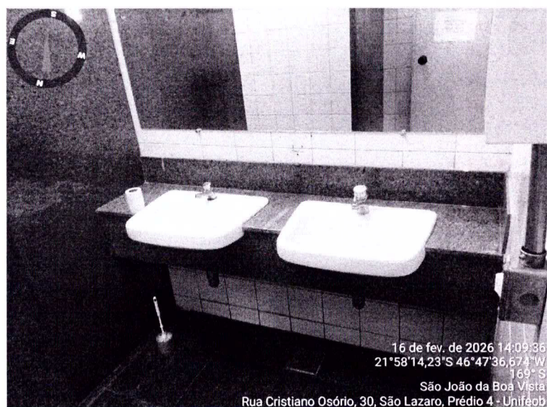
44 - Foto do banheiro - pavimento térreo.
