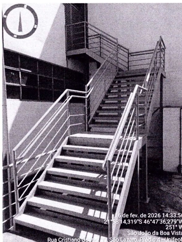
19 - Foto da escada de emergencia, corredor externo.
