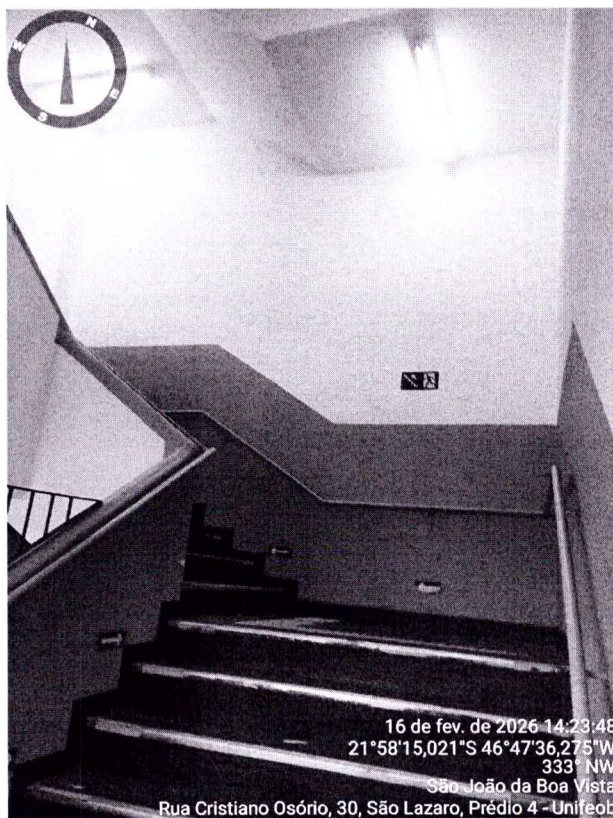
61 - Foto da escada - pavimento inferior - térreo.
