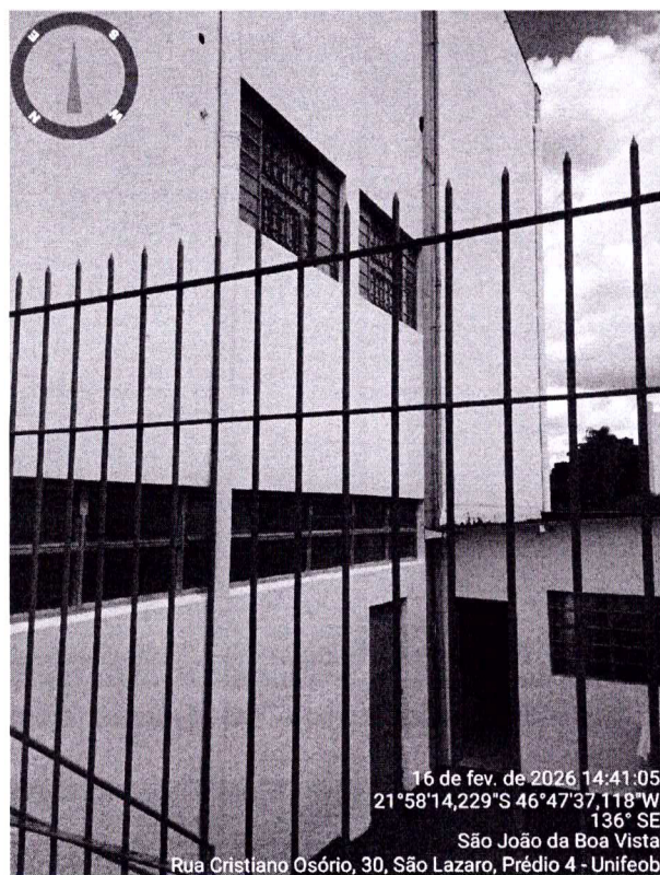
15 - Foto do fundo do prédio.
