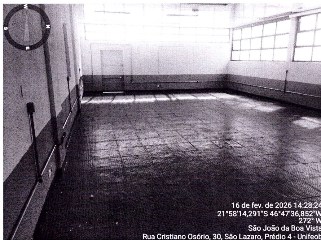
77 - Foto da sala de aula - pavimento inferior.
