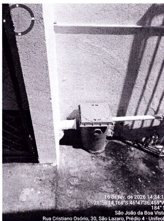
18 - Foto da caixa de gordura, corredor externo.
