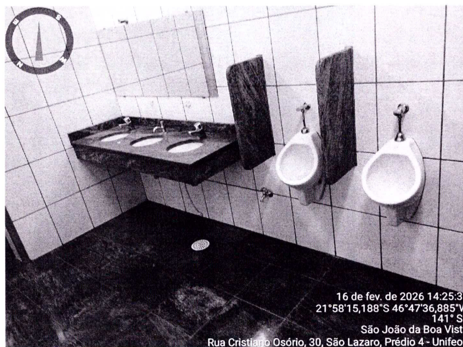
68 - Foto do banheiro - pavimento inferior.
