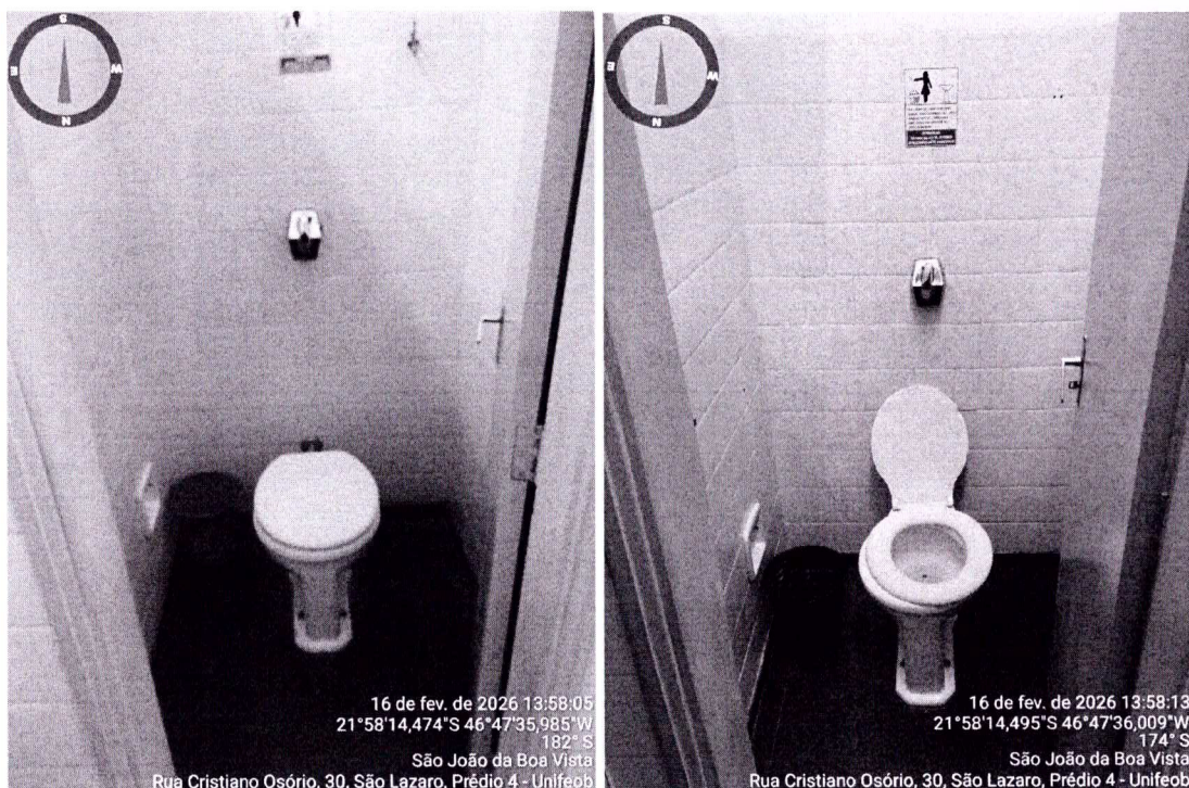
27 - Foto do banheiro - pavimento superior.
